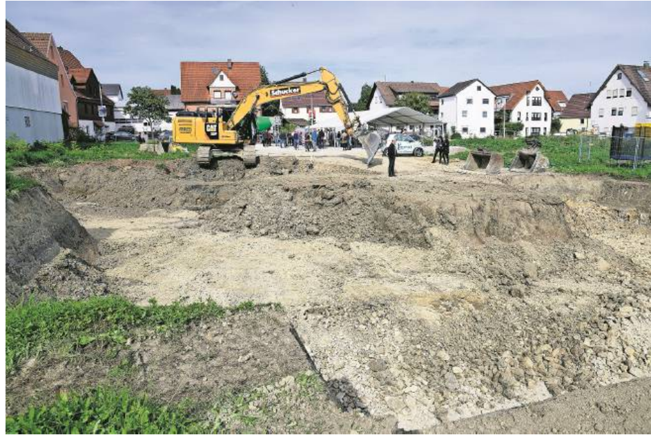
Der Bagger hat sich schon vor dem Spatenstich ans Werk gemacht
