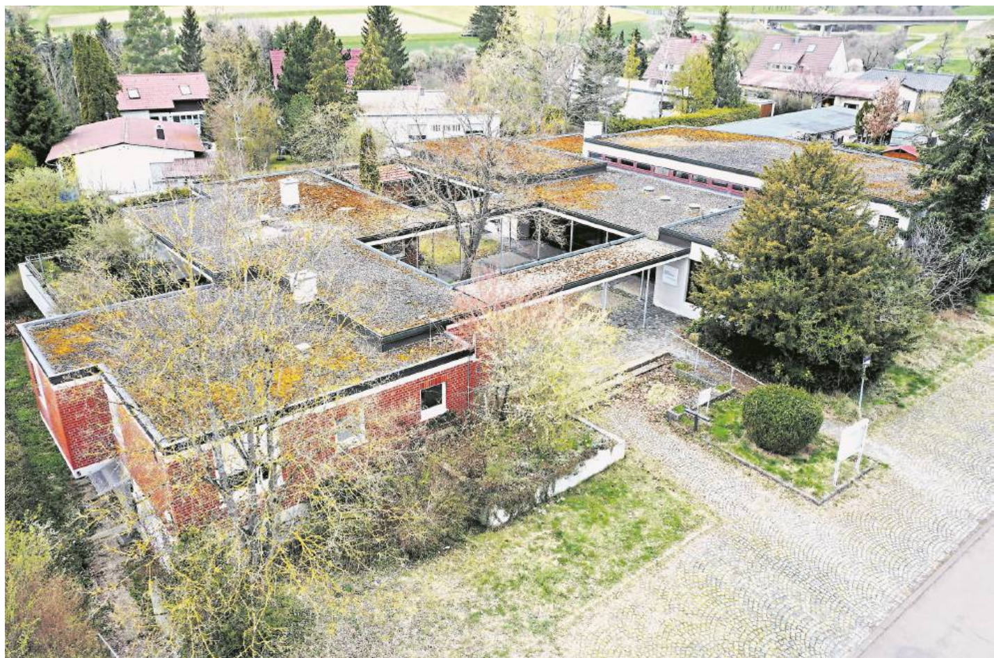
Das über 50 Jahre alte Bestandsgebäude weicht zwei Hauptbaukörpern in Flachdachform
