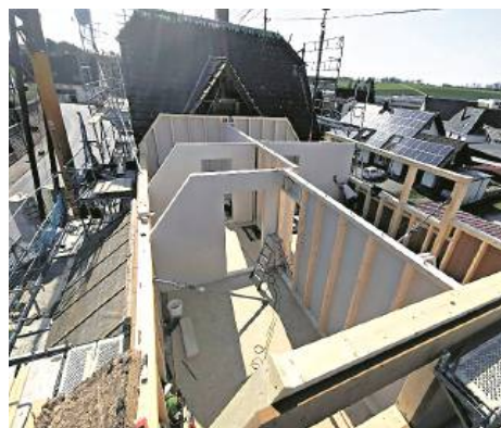
Ein Projekt im Baufortschritt
