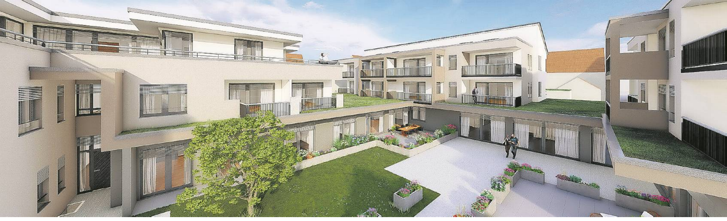
„Lebens(t)räume im Hofgarten“: In zentraler Lage in Öschelbronn entsteht unter anderem eine Pflege-WG – Bauherr ist die Graf Wohnbau GmbH
